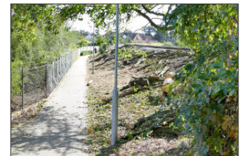
Odstranění náletové zeleně podél trati, foto hn
