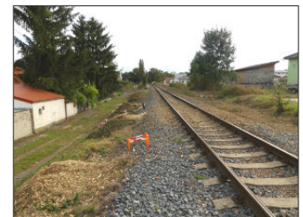
Příprava na opravu kolejového svršku směr Čelákovice, foto mj
