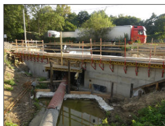
Stav rekonstrukce mostku v Kabelíně k 13. 9. 2020, foto mj
