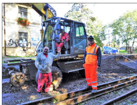
Pracovníci SŽDC v říjnu 2019 vyměnili část kolejí a na toušeňském nádraží zvýšili nástupiště, foto jvk
