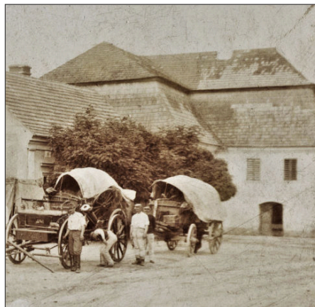
Zájezdní hostinec s mansardovou střechou (asi 1890)
