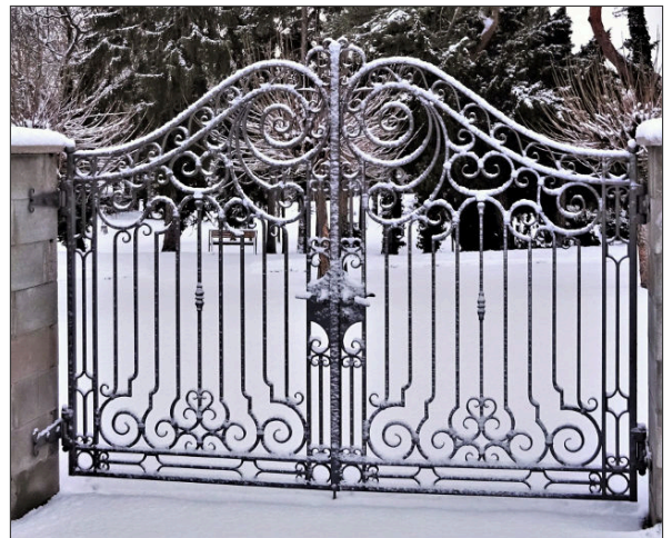
Zdobná vrata do Parku profesora Procházky z roku 2016; konstrukci navrhl a vyrobil umělecký kovář Daniel Tremil z Horních Počernic
